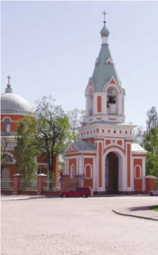
Haminan Pyhien apostolien Pietarin ja Paavalin kirkon kellotornin korjaus on saatu päätökseen syksyn 2007 aikana. Korjaus tuli maksamaan 75.000 euroa. Kirkkokuntamme keskusrahastolta saimme 45.000 euron avustuksen. Kellotornin peruskorjaukseen ei tarvittu pankkilainaa.
