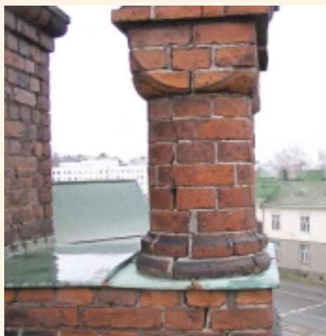
Murtuma kellotornin tulipilarissa. Kuva: IKJ Rakennus Oy
