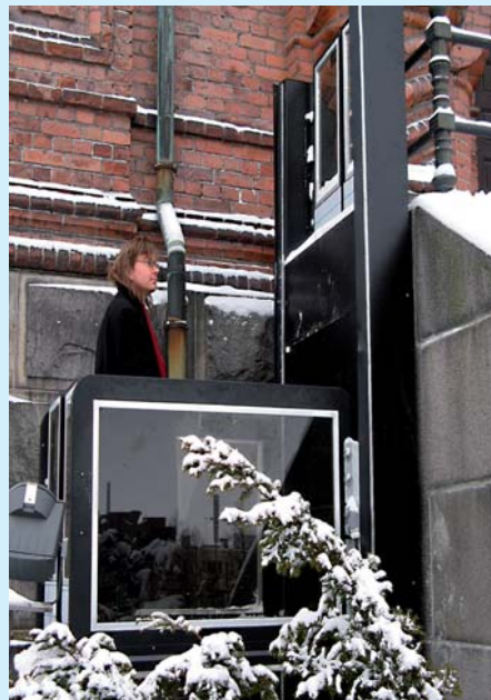
■ Vahtimestari Mika Kangasaho testaa hissiä sen asennusvaiheessa.
